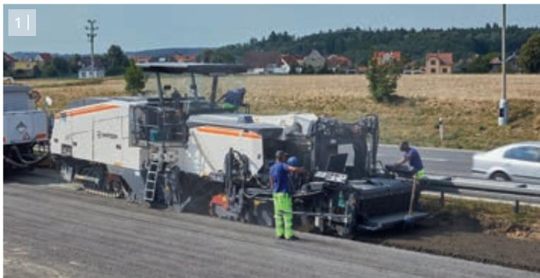
1 | Kaltrecycling in-situ mit dem Kaltrecycler W 240 CRi und integrierter Einbaubohle.
