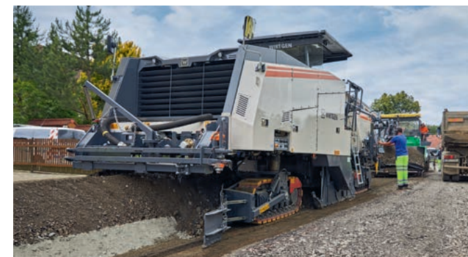
W 240 CRi na largura total da pista, incluindo pré-fresagem lateral e pavimentadora
