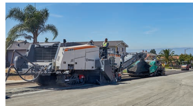
W 380 CRi com correia de descarga e largura de trabalho de 3,8 m, incluindo a pavimentadora
