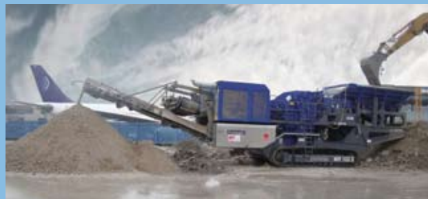
Il modello MC 122 durante la frantumazione di materiale di demolizione contenente ferro.
