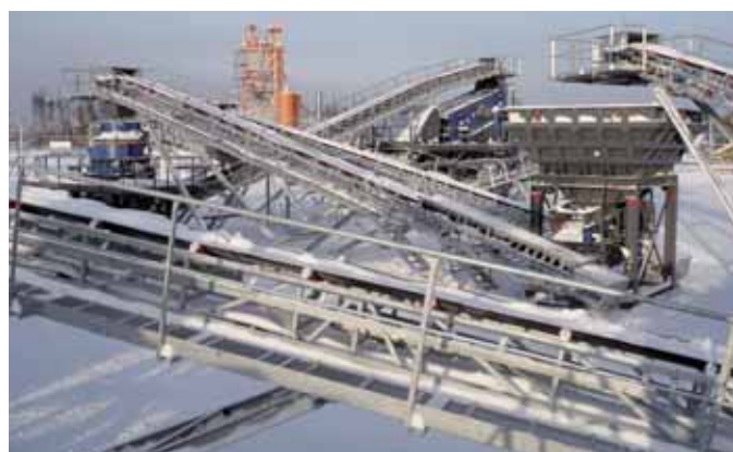
Работа мобильных установок может быть очень равномерной благодаря большому запасу материала в промежуточных точках.
