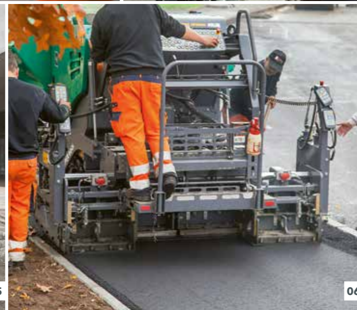
04 Alle wichtigen Einbaufunktionen können über die beiden handlichen Bohlenfernbedienungen gesteuert werden. 05 Komplett integrierte Nivellierautomatik Niveltronic Basic. 06 Kombinierbar mit den Ausziehbohlen AB 200 und AB 220.
