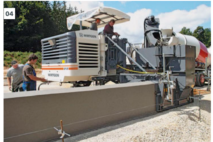
04 - 05 Die Gleitschalung ist wahlweise rechts oder links montierbar – der Umbau erfolgt binnen kürzester Zeit.
