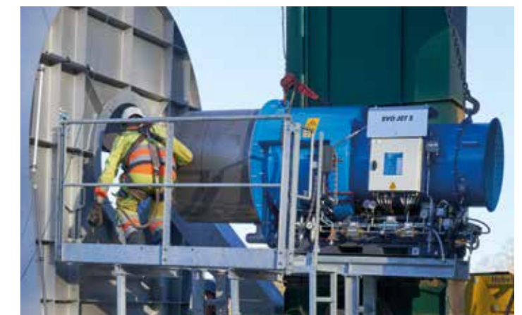
Retrofit palnika na paliwo stałe (drewno)
