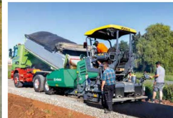
Beim Hochklappen der Behälterwände werden die LKW-Abdruckrollen automatisch mit nach oben geklappt.
