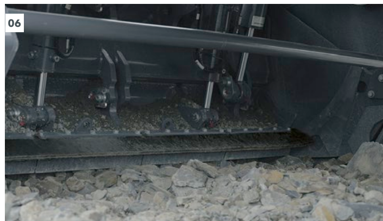
04 Grobes Gestein baut sich vor der Einzugsklappe auf. 05 Einzugsklappe wird manuell geöffnet und das Gestein bei Überfahrt ins Brech- und Mischgehäuse geschoben. 06 Einzugsklappe wird geschlossen, um den Auswurf nach vorne zu minimieren.
