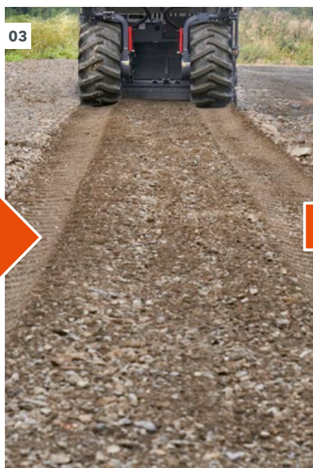
03 Brech- und Mischergebnis: bewerten und nachjustieren der Parameter bei Bedarf
